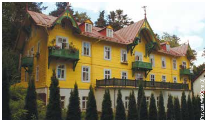
Budynek przy ul. Kulczyńskiego 4 w Iwoniczu-Zdroju
