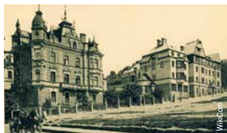
Wille i domy letniskowe w Karlsbadzie czyli Karlovych Varach na widokówce z 1908 r. wydanej przez Brück & Sohn
